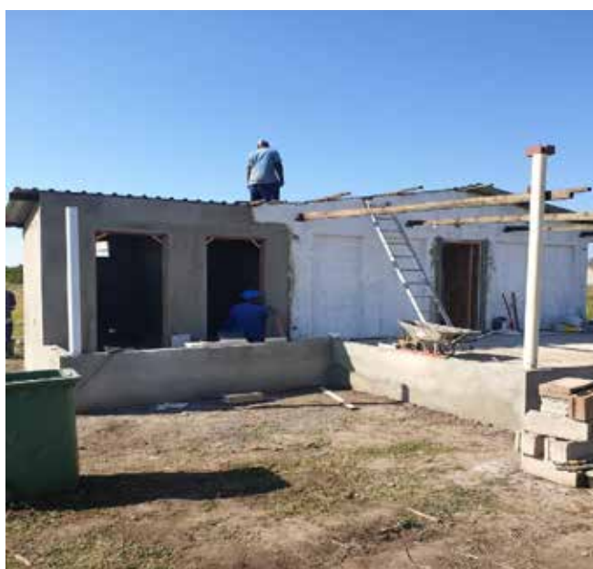
Costruzione orfanotrofio Casa San Francesco e Santa Chiara Maputo
